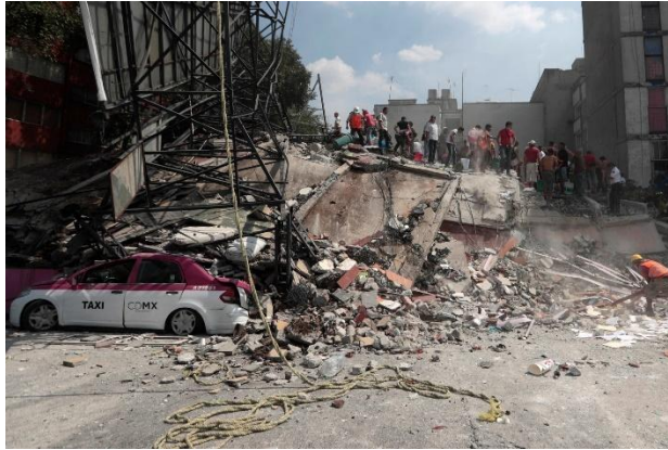
Figura 3 Después del terremoto en México.
