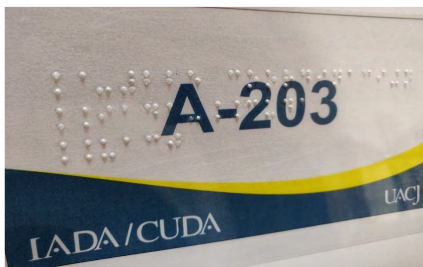
Figura 89. Señalética con impresión convencional y adecuación en braille
