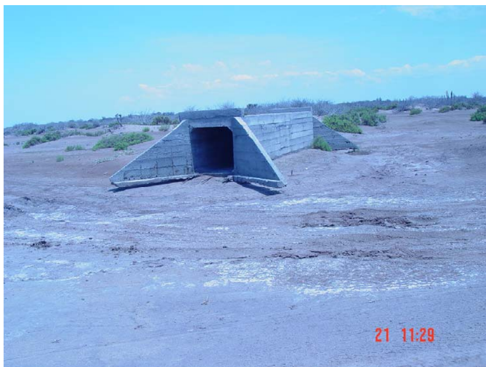
Fig. 19. Detalle de puente en el camino que conduciría a Mélagos.
