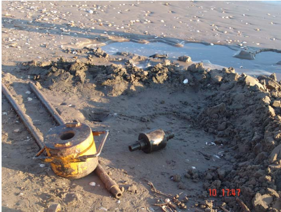
Fig. 52. Perforación exploratoria en el punto del segundo sondeo.
