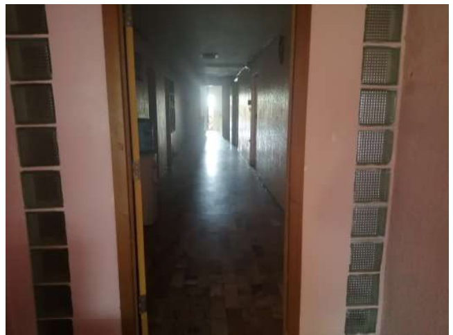
Imagen 33: Puerta al pasillo
