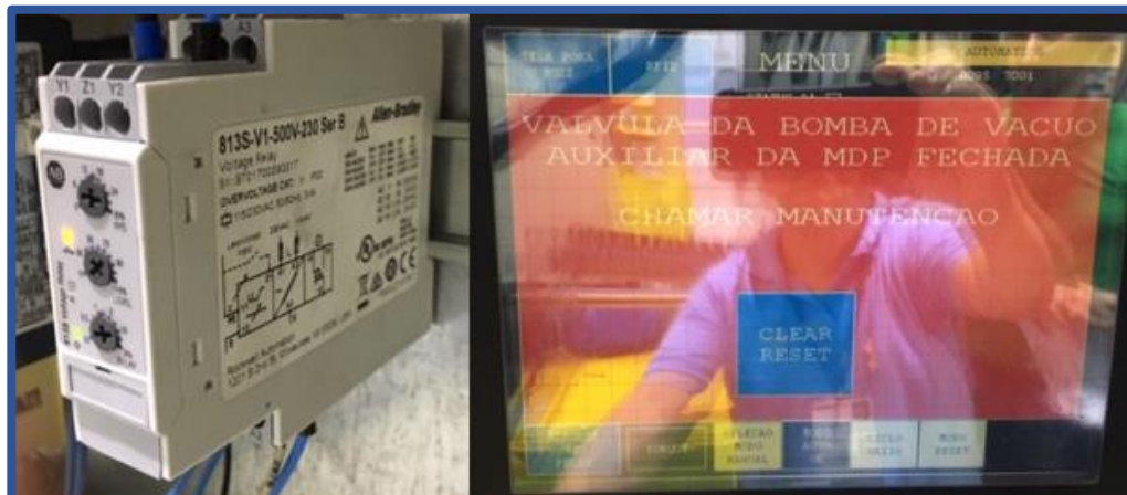
Figura 3.23. Monitor de fase eléctrica
