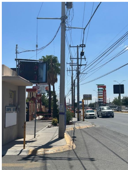
Figura 105. Elementos de contaminación visual, tramo 1: cableado
