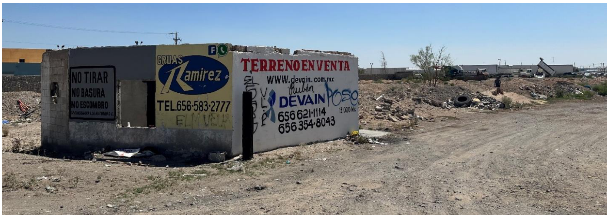
Figura 137. Elementos de contaminación visual, tramo 3, basura, grafiti y edificio deteriorado
