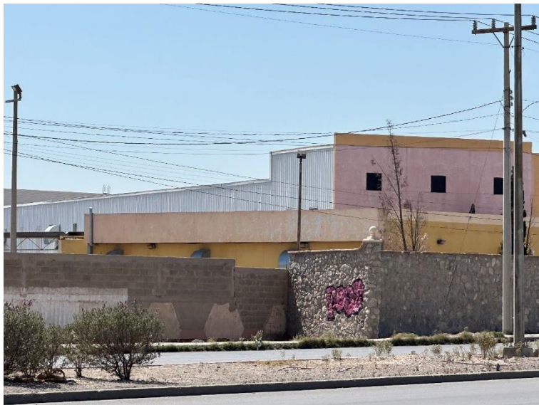
Figura 134. Elementos de contaminación visual, tramo 3, grafiti y fachada deteriorada
