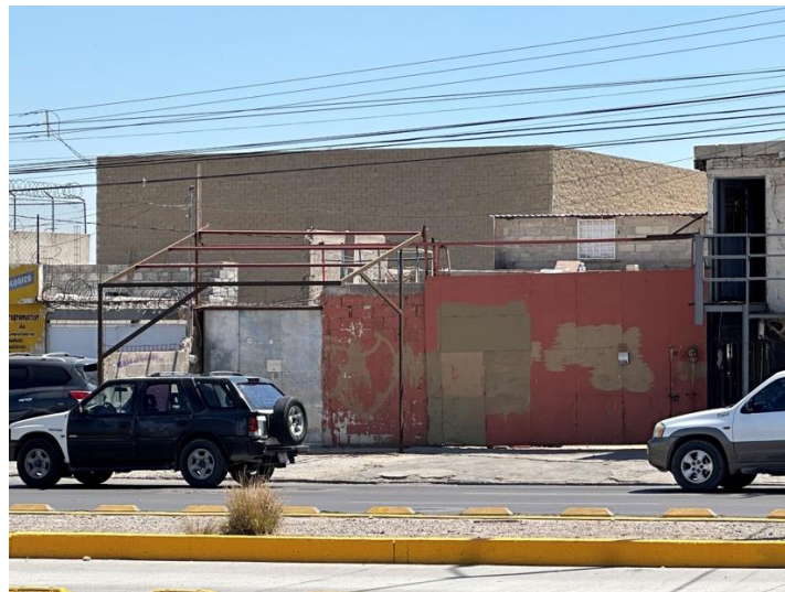
Figura 122. Elementos de contaminación visual, tramo 2, fachada
