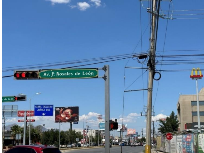
Figura 108. Elementos de contaminación visual, tramo 1, barda y cableado
