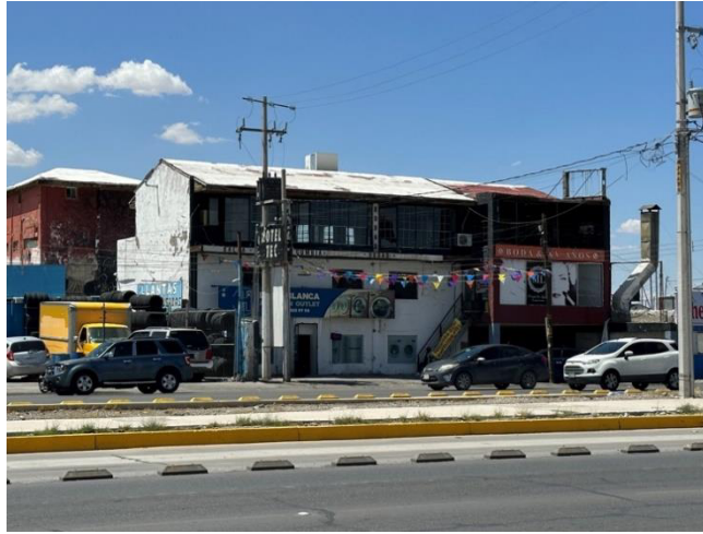
Figura 107. Elementos de contaminación visual, tramo 1, cableado y fachada
