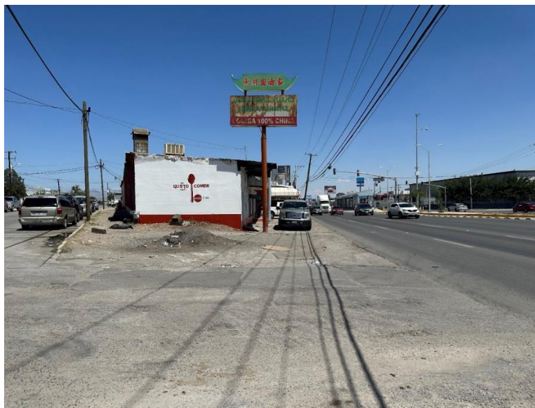
Figura 123. Elementos de contaminación visual, tramo 2, banqueta, cableado y postes
