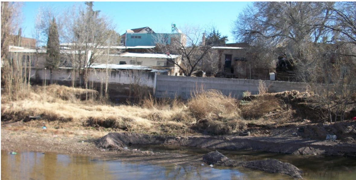
Figura 32 Fachadas de muros a los cauces
