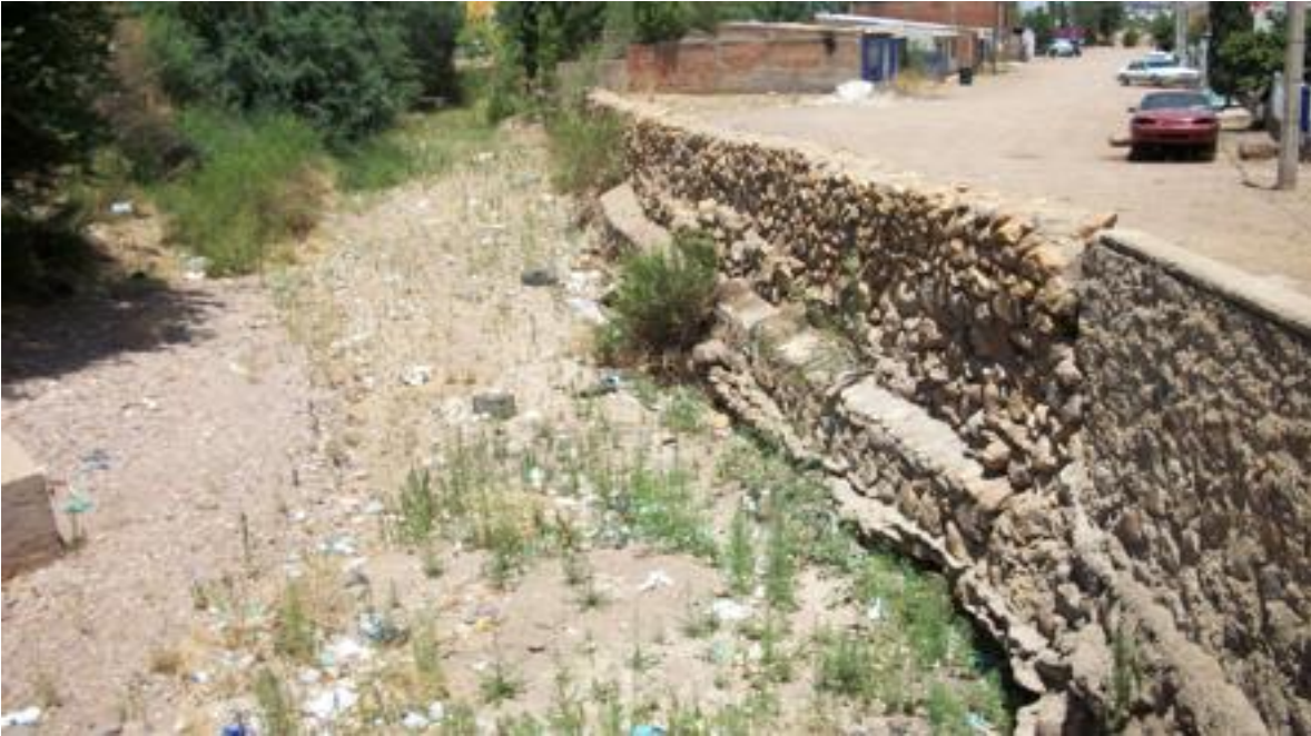
Figura 22 Muro de contención de piedra C.56
