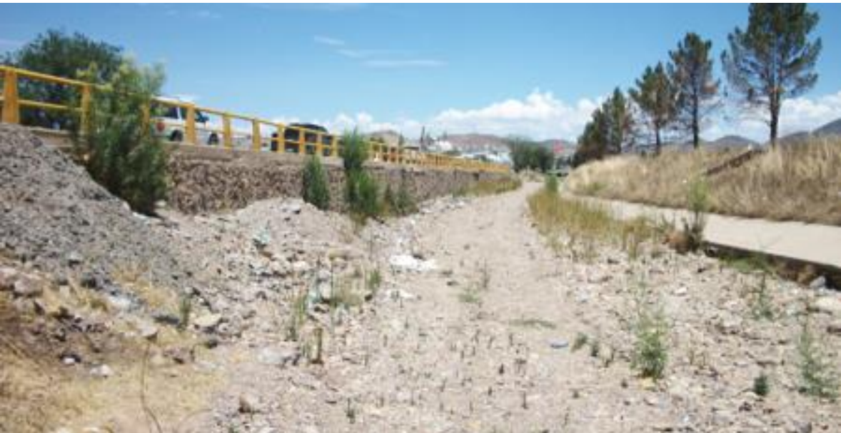
Figura 23 Cauce urbano al sur poniente de la ciudad
