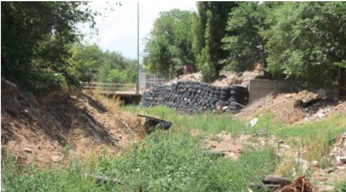
Figura 21 Muro de construcción de llantas.
