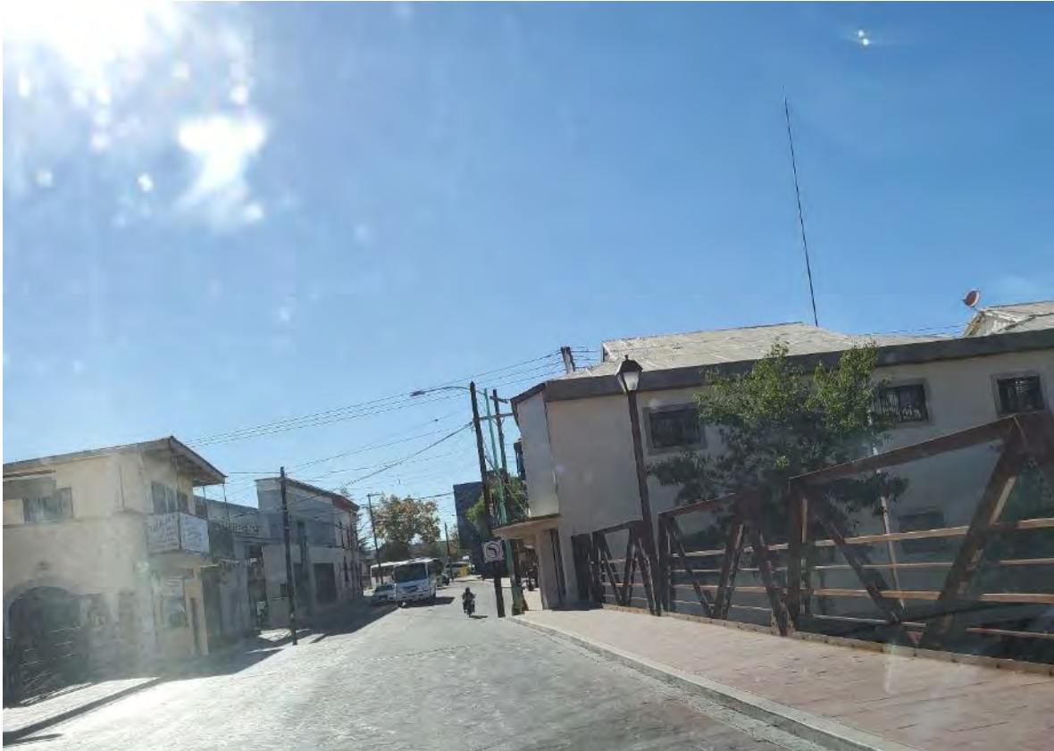
Figura 71: Fotografía del puente Guanajuato actual. Fuente: Archivo personal 2021.
