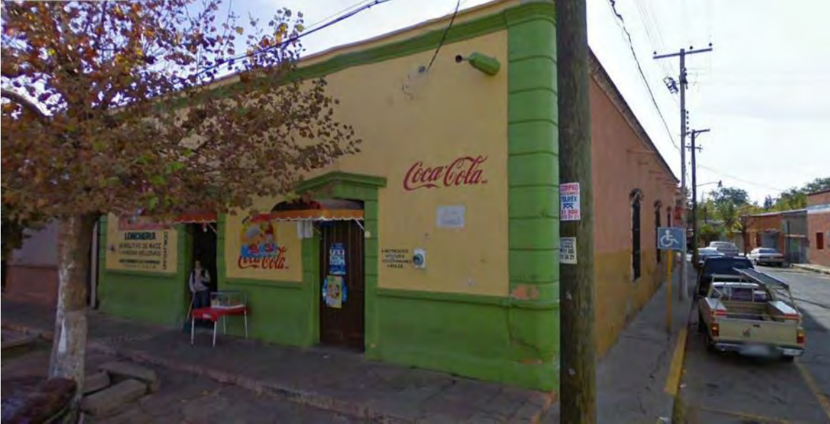
Figura 65: Antigua casa Arras (la construcción previa a la demolición). Fuente: Recorrido en Google Earth, 2011.
