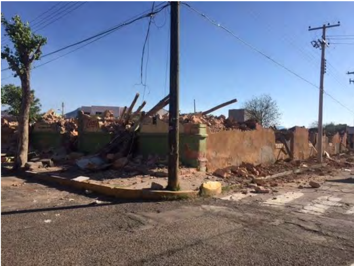
Figura 66: Durante la demolición de la casa Arras. Fuente: INAH 2021.
