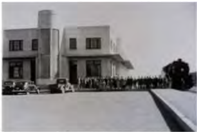
Antiguas oficinas del ferrocarril
