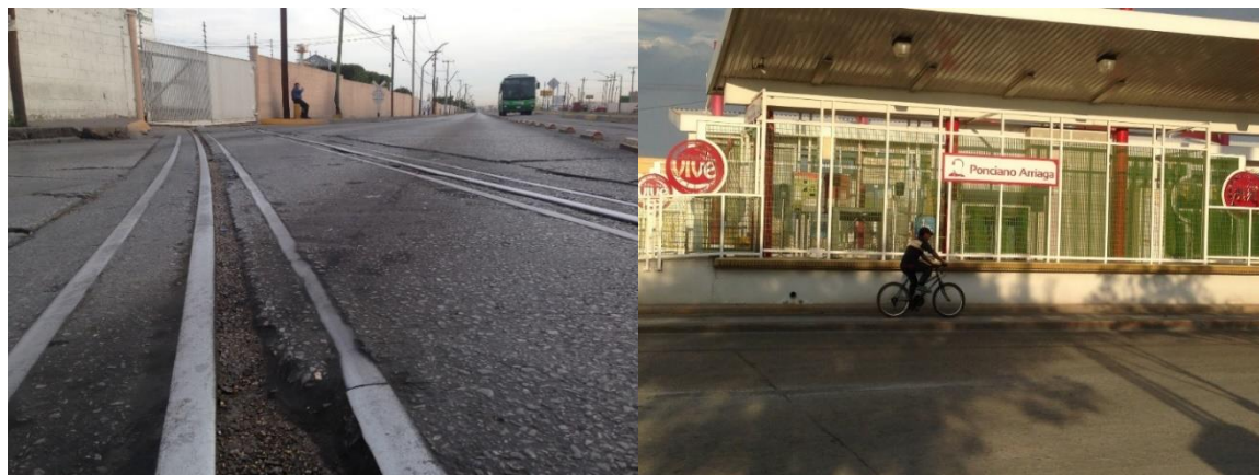
Figura 45: Condición de vialidades en mal estado y uso del carril del BRT para desplazamientos ciclistas. Fuente: Imagen tomada el 03/07/2017 por Edibray Acosta
