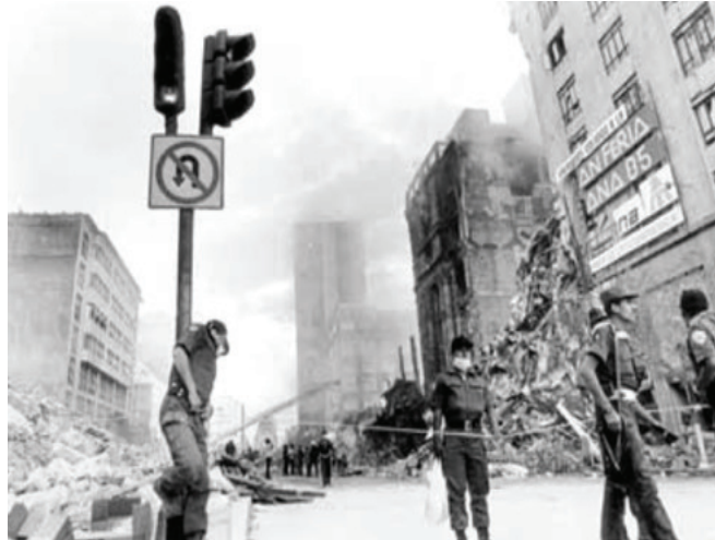
Figura 15. Después del sismo
