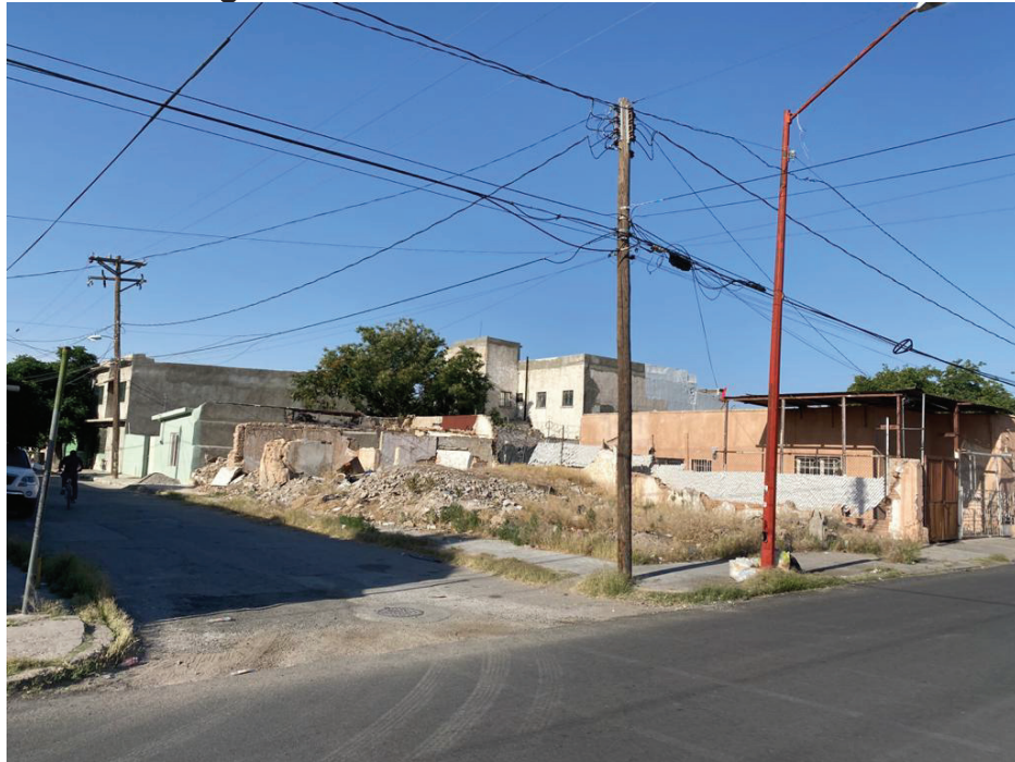
Figura 33. Lote en estado con deterioro
