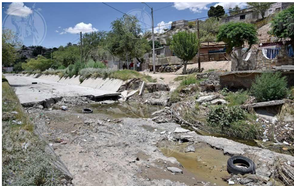
Fotografía 1: Afectaciones en las vialidades por los escurrimientos pluviales
