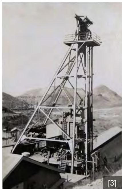
Figura 18. Jaulas de extracción y castilletes en mina El Potosí y mina Santo Domingo. [1] Diagrama que muestra profundidad del Tiro 1 (der.) con sus dos estaciones de carga en los niveles 20 y 21 y el Tiro 5 con una estación de carga en nivel 20; [2] Estado actual de cucharones de extracción ( skips ) y jaulas colgantes ( cages ) del Tiro no. 1. [3] Castillete del Tiro no. 1 circa 1936, a la izquierda se aprecia la nueva estructura para alojar las tolvas de mineral propuesto en 1931; [4] Castillete del Tiro no. 5 circa 1936, se aprecia a la izquierda la estructura adosada de la quebradora, al frente, piezas de adobe secándose al sol. Fuente: [1] Plano anexo al Informe del Ing. David V. Fennessy, a W. J. Quigly, Presidente de EPMCo, El Paso, Texas, 28 de diciembre de 1934. AHEP, SA, caja 36, expediente 35; [2] Fotografía tomada en 2017. Autor Javier Hernández; [3] y [4] fotografías anexas al reporte de ingeniería no. 2789 ½, 1° de febrero de 1936. AHEP, AM, caja 10 expediente 14.
