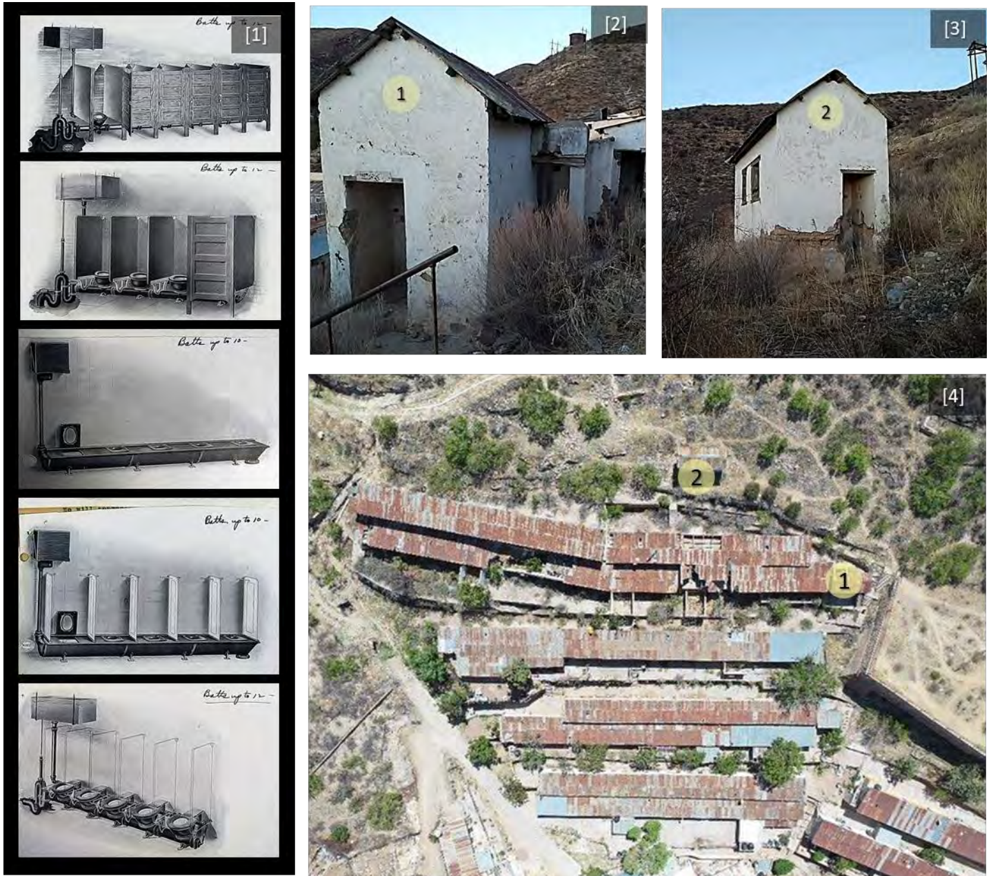
Figura 59. Instalaciones sanitarias en “las cuadras de Santo Domingo”. [1] Modelos de excusados industriales en el mercado evaluados para la su instalación por EPMco en 1932; [2] y [3] instalación de servicios sanitarios habilitados en el barrio obrero; [4] localización en planta de los servicios sanitarios en el barrio obrero.
