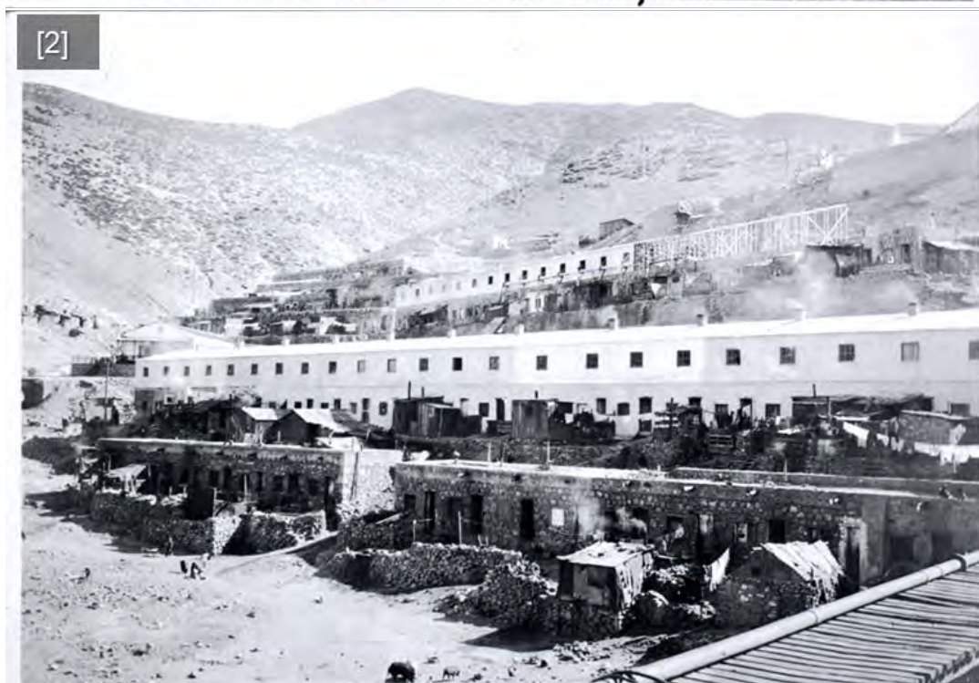
Figura 57. Ampliación de cuadras de obreros en segundo nivel con sistema 'plaster wall'. [1] Se aprecia el avance del proceso constructivo en el armado de la estructura de madera en muros que luego recibirían una malla metálica a la que se le aplicó emplaste de cemento-arena; [2] al centro se aprecia la conclusión de los trabajos en una de las cuadras y en la parte superior la continuación de los trabajos en otra cuadra, en la parte inferior derecha se aprecia una sección del puente peatonal de madera desde donde fue realizada la toma fotográfica. En ambas fotografías se destaca la habilitación de estructuras adosadas a las crujías de las cuadras, reflejo de familias que adaptaron sus espacios de habitación.
