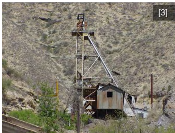
Figura 3. Cambio de fuerza motriz en malacate del Tiro no. 1, mina El Potosí.
