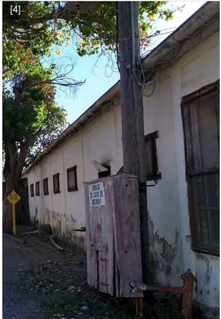
Figura 72. Equipo contra incendio en Santo Domingo. [1] Gráfico de casa de manguera e hidrante propuesto por Jay L. Harman Company ingenieros de protección contra incendios. [2], [3] y [4] estado actual de las instalaciones del equipo contra incendios en la Unidad de Santo Domingo.
