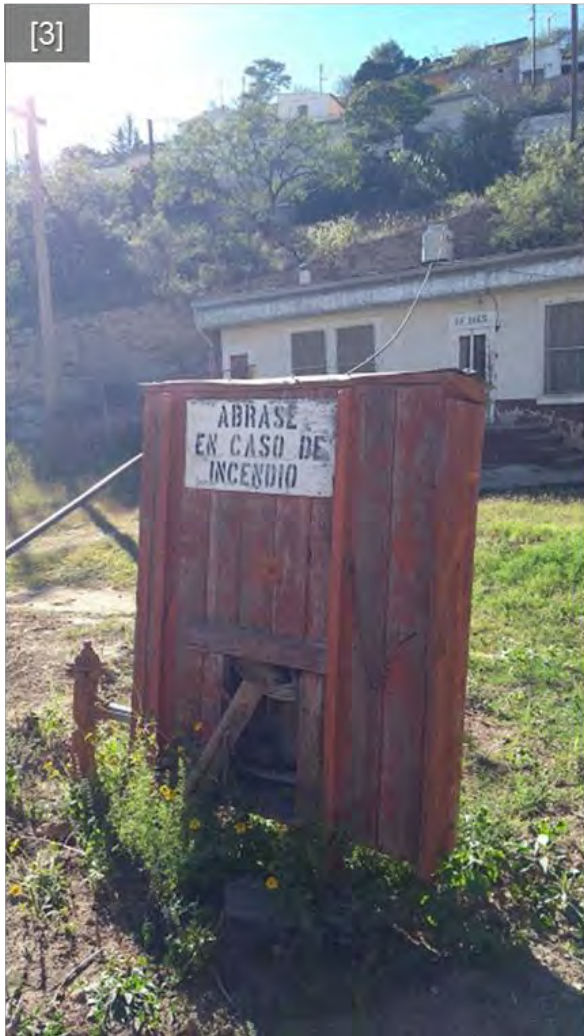
Figura 72. Equipo contra incendio en Santo Domingo. [1] Gráfico de casa de manguera e hidrante propuesto por Jay L. Harman Company ingenieros de protección contra incendios. [2], [3] y [4] estado actual de las instalaciones del equipo contra incendios en la Unidad de Santo Domingo.
