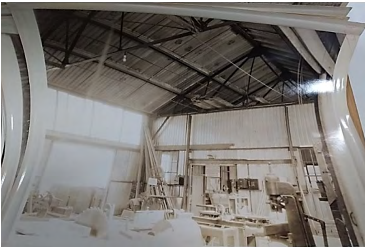
Figura 14. Vista exterior e interior de taller de carpintería en Santo Domingo, año 1928. Se aprecia su armazón de estructura metálica con enchapado de lámina corrugada en muros y cubiertas. Fuente: AHEP, caja s/n, fotografías nos. 3 y 5.
