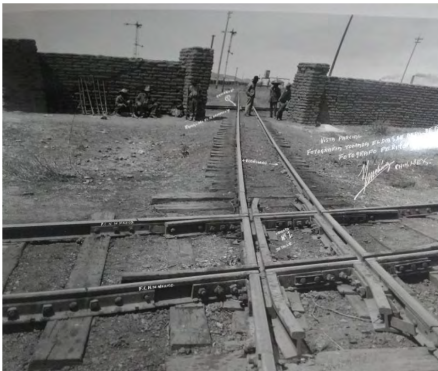
Figura 24. Detalle del cruzamiento de vías ferroviarias entre el Ferrocarril Industrial Económico Potosí – Chihuahua y el Ferrocarril Mineral de Chihuahua cerca de la Estación Morse. [arriba] Se observa la casa del semáforo y una comitiva de inspección en el sitio. [abajo] Se observa el cruzamiento de la de la vía del FFCC Industrial con FFCC Nacionales y su penetración -atravesando una barda perimetral de adobe- hacia la Planta Fundidora Ávalos, en la imagen aparecen también los operarios de ferrocarril en su cargo como cambiadores de vía.
