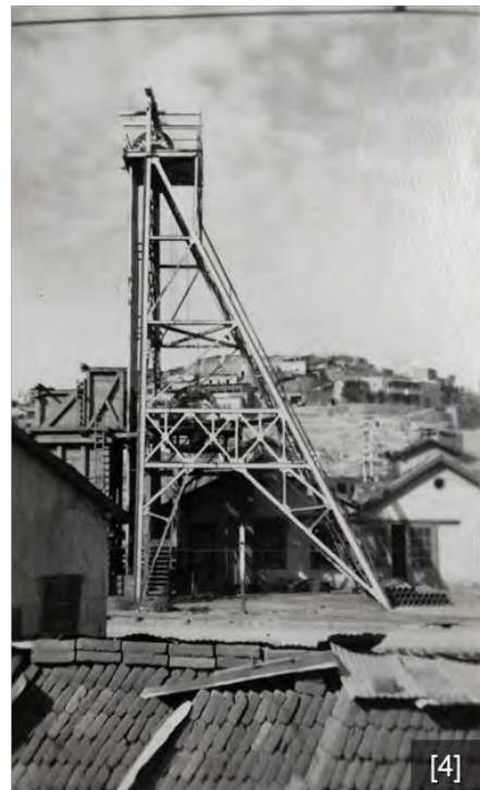
Figura 18. Jaulas de extracción y castilletes en mina El Potosí y mina Santo Domingo. [1] Diagrama que muestra profundidad del Tiro 1 (der.) con sus dos estaciones de carga en los niveles 20 y 21 y el Tiro 5 con una estación de carga en nivel 20; [2] Estado actual de cucharones de extracción ( skips ) y jaulas colgantes ( cages ) del Tiro no. 1. [3] Castillete del Tiro no. 1 circa 1936, a la izquierda se aprecia la nueva estructura para alojar las tolvas de mineral propuesto en 1931; [4] Castillete del Tiro no. 5 circa 1936, se aprecia a la izquierda la estructura adosada de la quebradora, al frente, piezas de adobe secándose al sol. Fuente: [1] Plano anexo al Informe del Ing. David V. Fennessy, a W. J. Quigly, Presidente de EPMCo, El Paso, Texas, 28 de diciembre de 1934. AHEP, SA, caja 36, expediente 35; [2] Fotografía tomada en 2017. Autor Javier Hernández; [3] y [4] fotografías anexas al reporte de ingeniería no. 2789 ½, 1° de febrero de 1936. AHEP, AM, caja 10 expediente 14.
