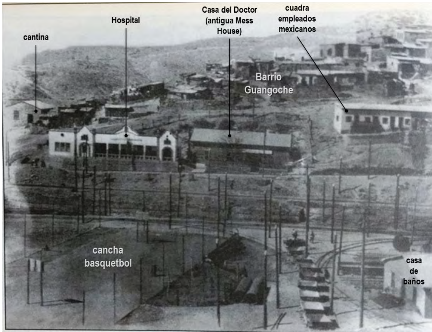
Figura 66. Instalaciones de El Potosi Mining Company en Santo Domingo., circa 1925. Vista de la sección Suroeste del conjunto, donde es posible apreciar la fachada inicial del Hospital de la compañía, una cancha de basquetbol y la antigua casa de baños, circa 1925.
