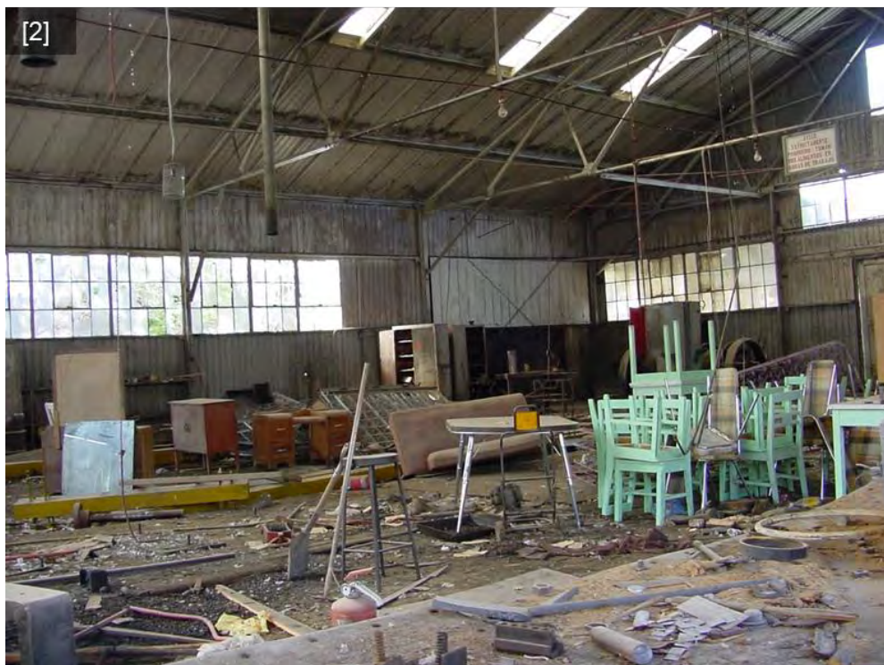
Figura 16. Taller mecánico en Santo Domingo. Comparativa entre el espacio contenedor del trabajo [1] se aprecia el ingreso de las vías férreas al local, para el mantenimiento de máquinas, locomotoras y carros de mina. Nave a dos aguas exenta, con armazón metálico para la estructura y cubierta de lámina metálica, paredes de enchapado de lámina corrugada, se observan tanques de aceite y a los trabajadores con delantal de trabajo; [2] imagen del año 2003, donde se aprecia que este local es utilizado como bodega de materiales diversos.
