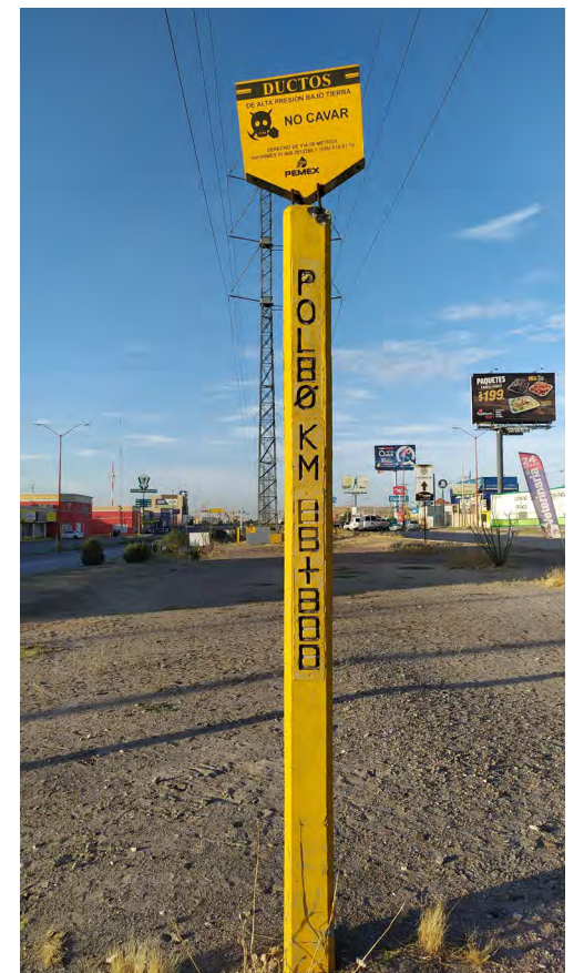
Imagen 6: señalamiento del gasoducto de Pemex. Foto Propia
