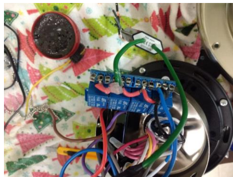
Figura 3.46: Solado de cables a terminales del relevador Fuente:Elaboración propia.
