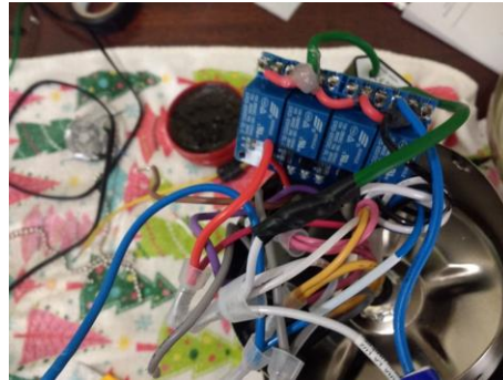
Figura 3.47: Pegado de cables a terminales del relevador Fuente:Elaboración propia.
