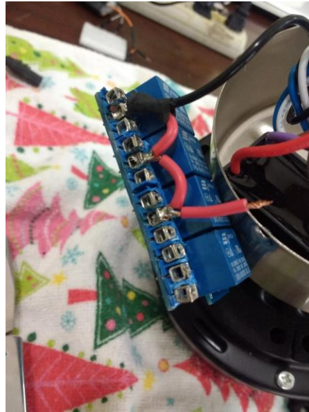
Figura 3.45: Solado de cables a terminales del relevador Fuente:Elaboración propia.
