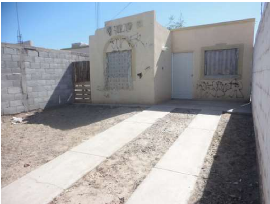
Imagen 18. Vivienda Ribera de los Alpes M50 Lote #8
