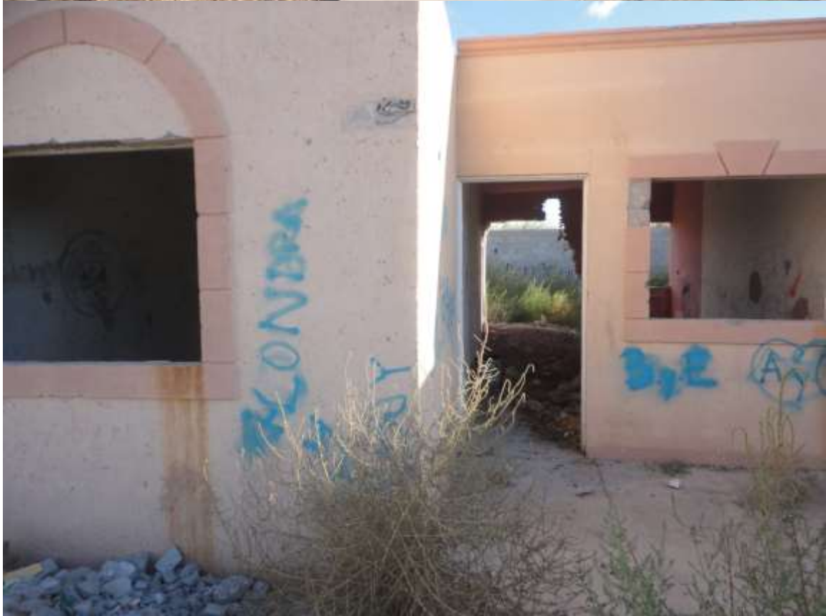
Imagen 12. Vivienda Ribera de los Alpes M53 Lote #9
