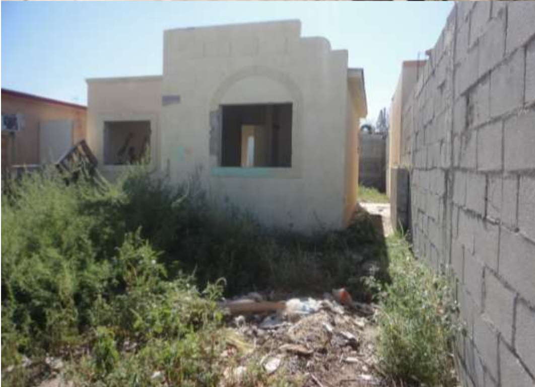
Imagen 4. Vivienda Ribera de los Pinos M48 Lote #18
