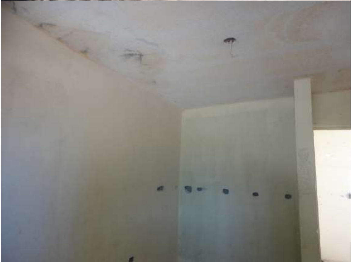
Imagen 19. Vivienda Ribera de los Alpes M49 Lote#50
