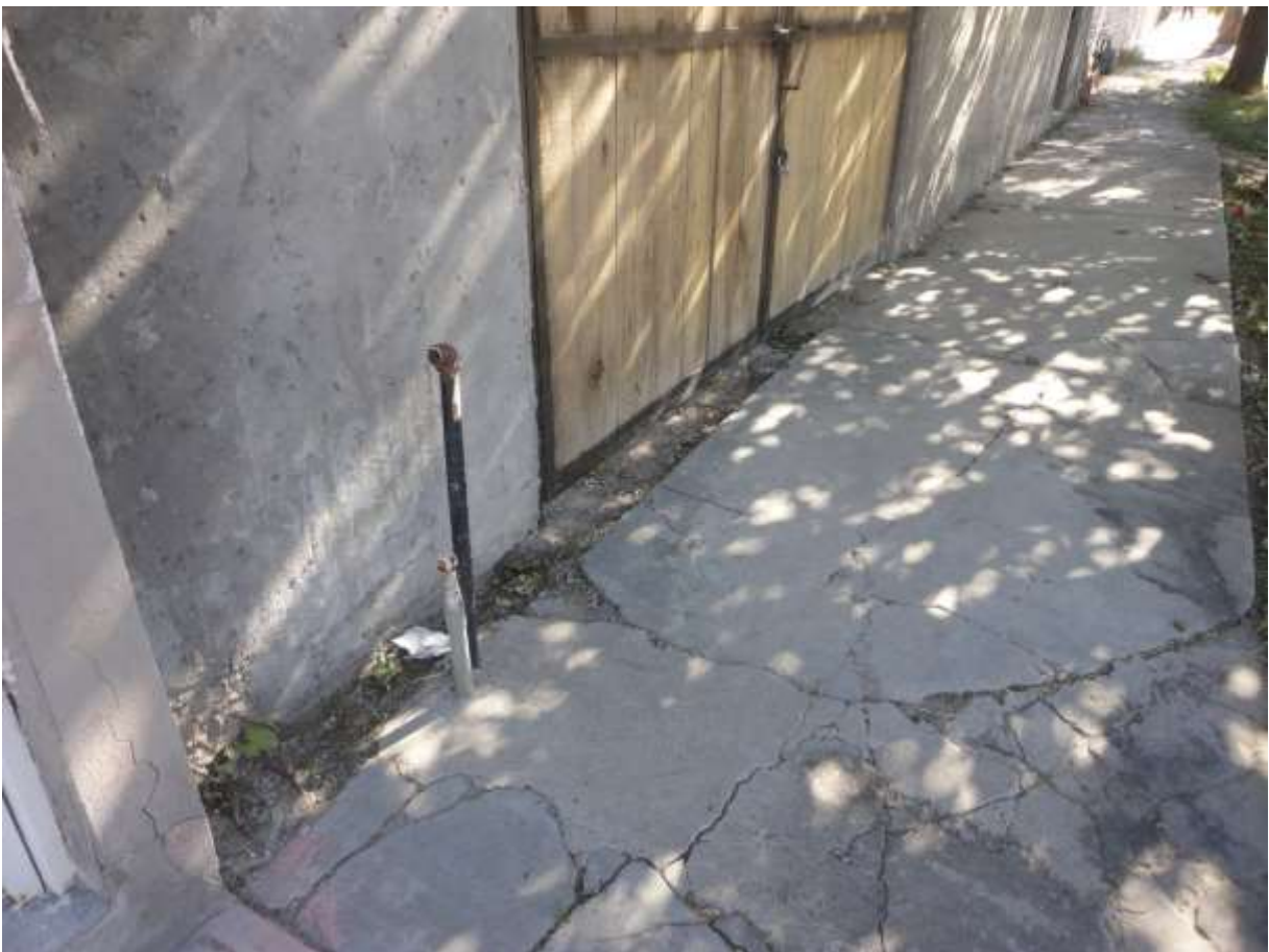
Imagen 42. Vivienda/obra negra Calle Rio Júcar SN
