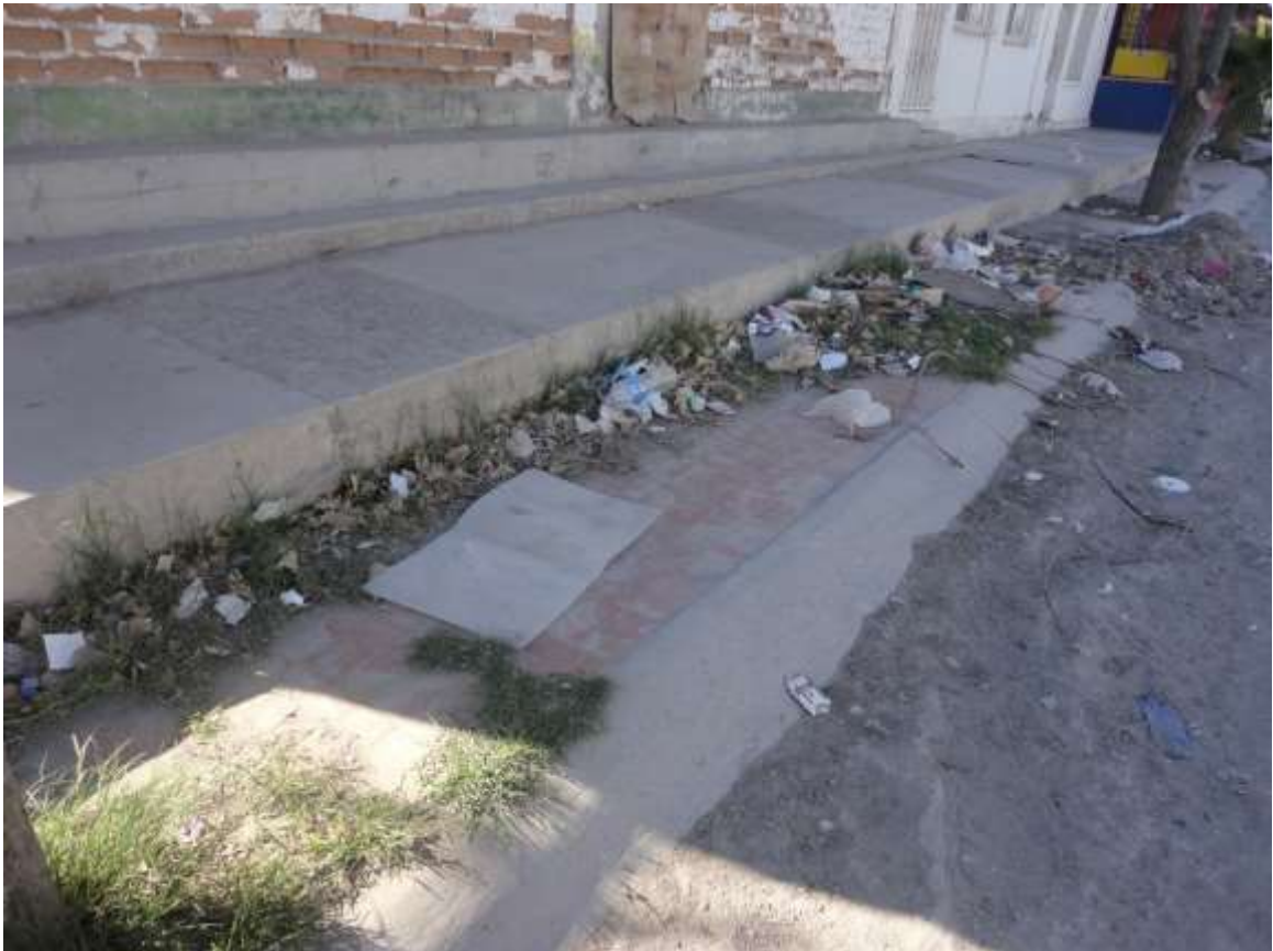
Imagen 34. Vivienda-Tienda Calle Paso del Norte SN
