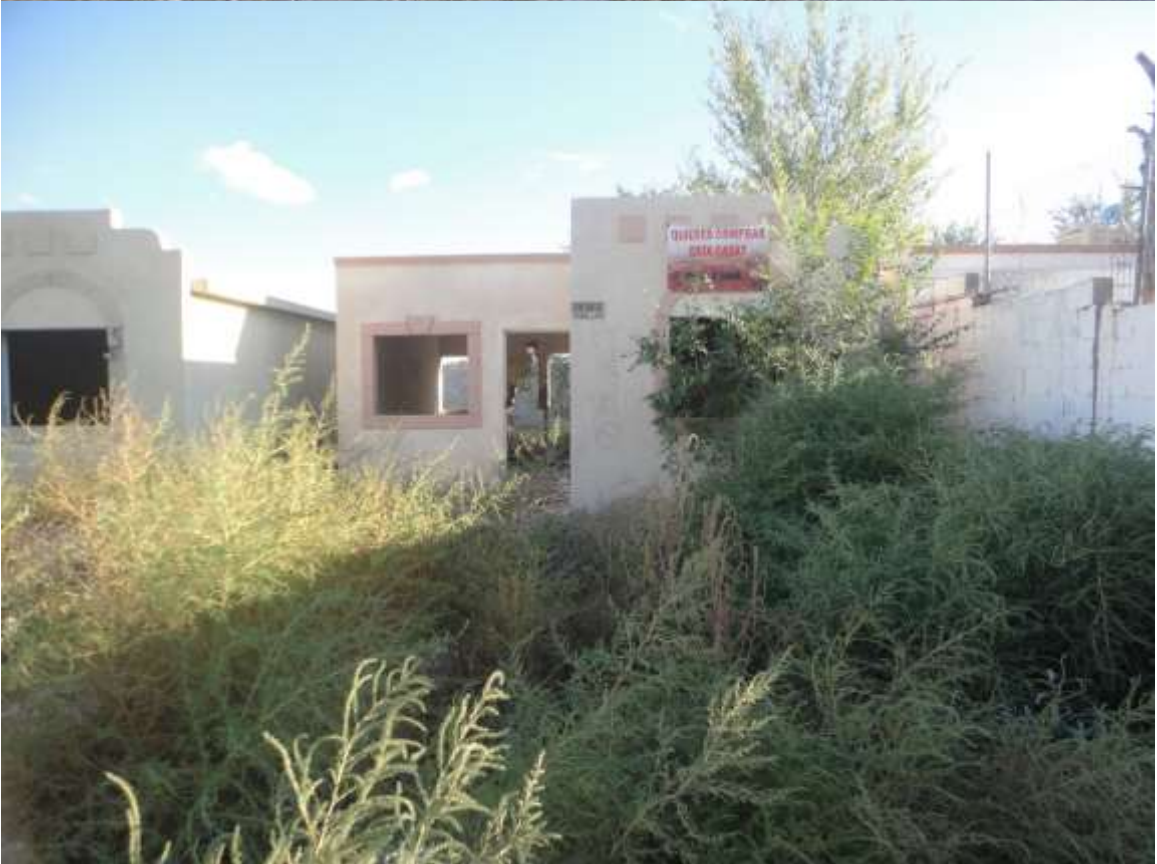
Imagen 11. Vivienda Ribera de los Alpes M53 Lote #2
