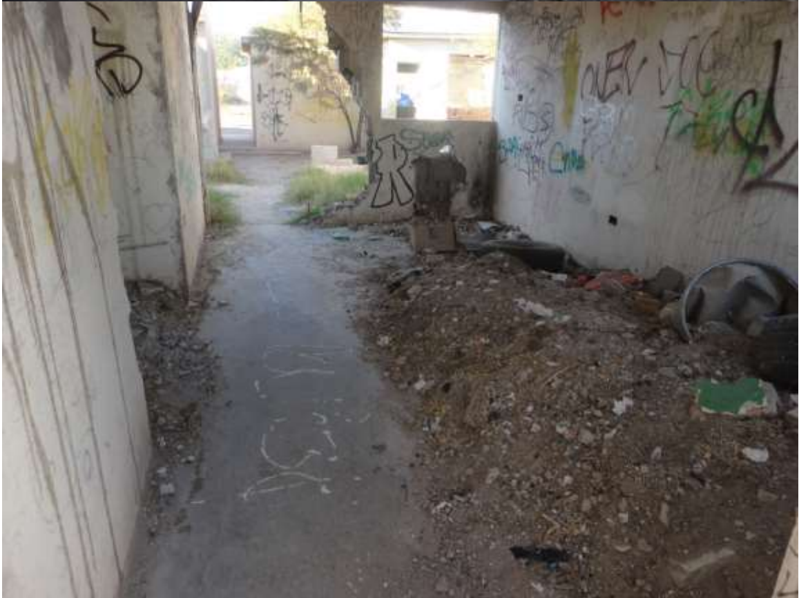
Imagen 9. Vivienda Ribera de los Alpes M52 Lote #31
