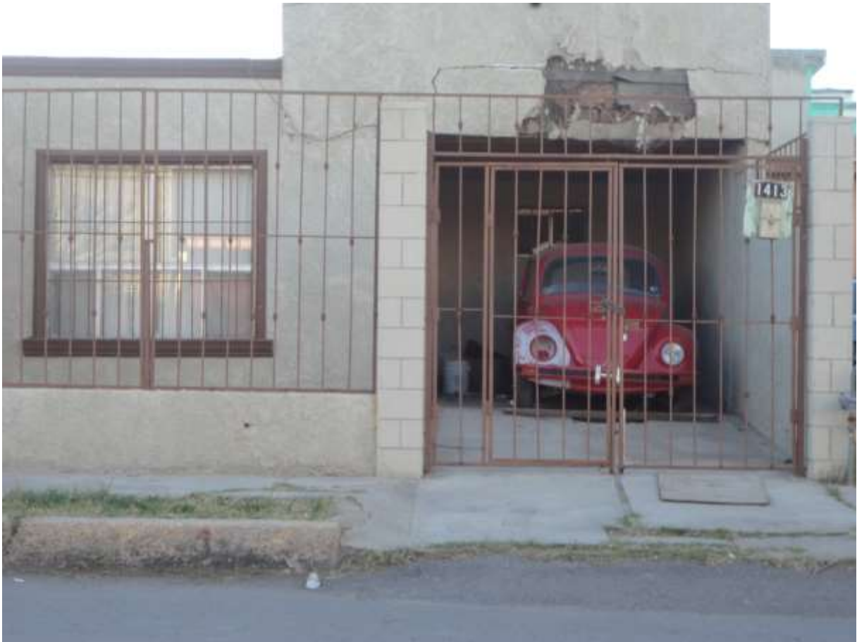
Imagen 45. Vivienda Calle Rio Júcar 1413
