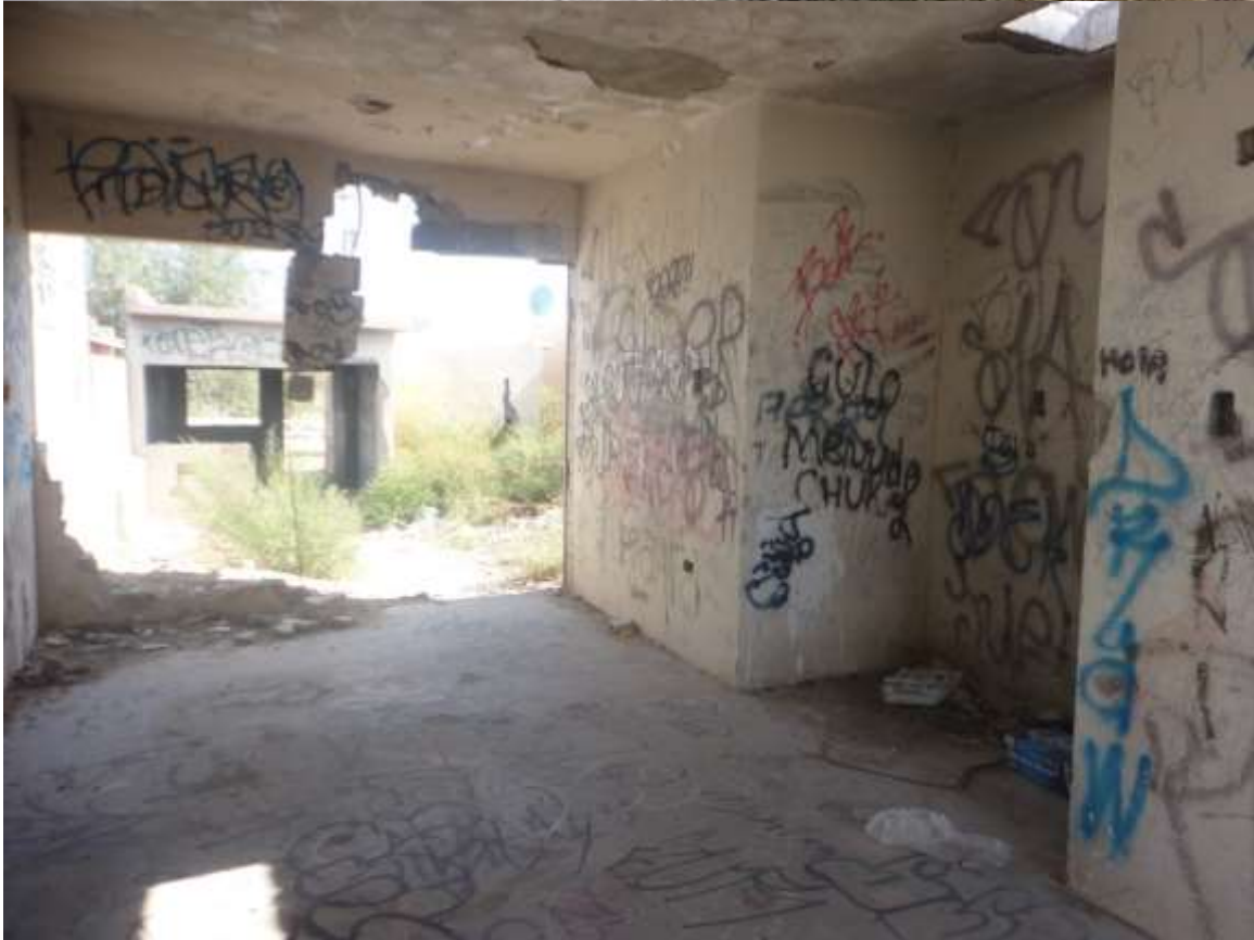
Imagen 3. Vivienda Ribera de los Alpes M49 Lote #39
