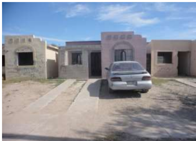
Imagen 25. Vivienda Ribera de los Alpes M49 Lote#37
