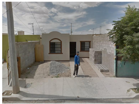
Figura 33. Viviendas en proceso de transformación
