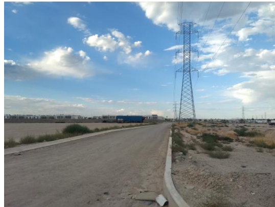
Figura 16. Foto de torre de alta tensión ubicada en camellón de vialidad en construcción. Fuente: Elaboración propia.
