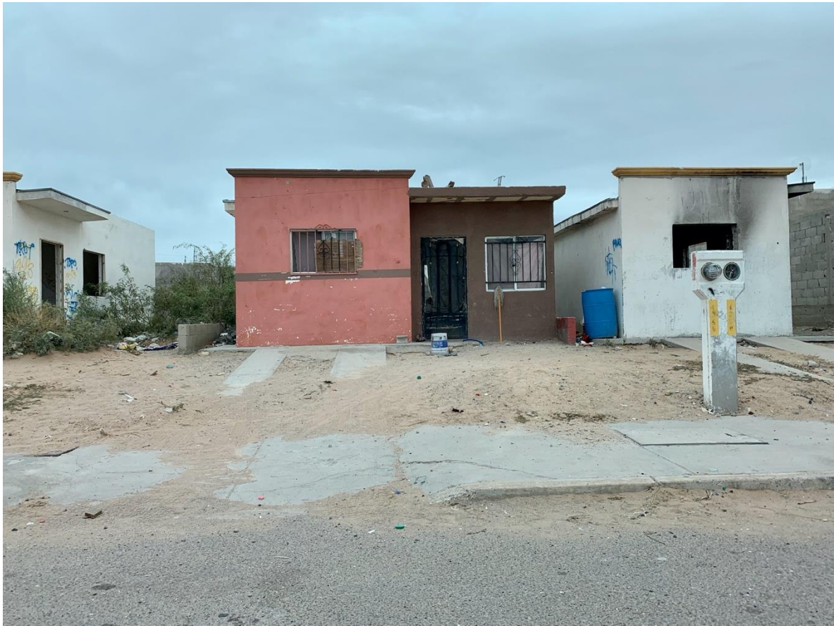
Vivienda en el área de Urbivilla del Cedro (Finca Bonita)
