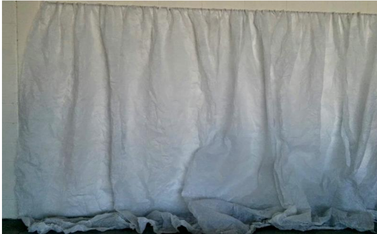
Ilustración 42. Pellón corrugado en pared. Fuente propia.
