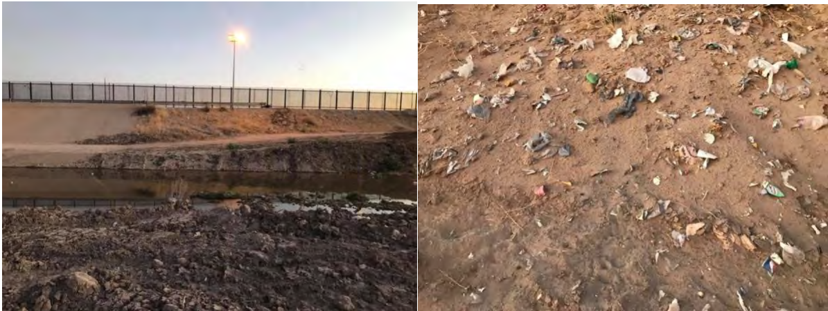
Imagen 71. Fin del canal pavimentado.
