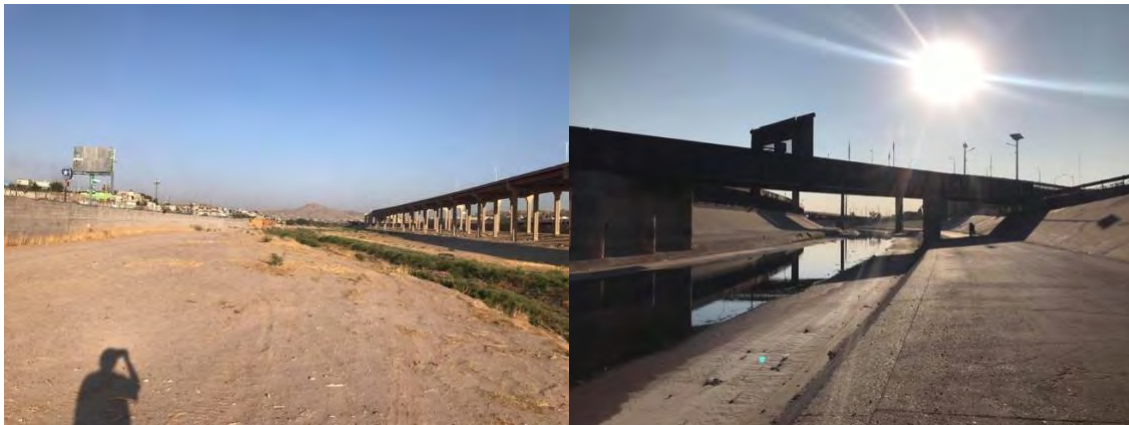
Imagen 65. Imágenes del recorrido. Puente negro. Inicio del canal pavimentado.
