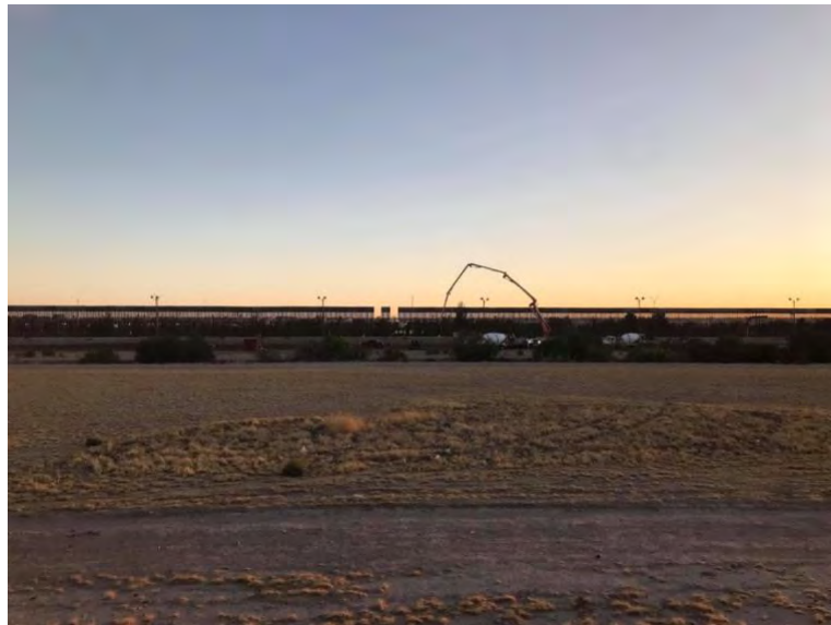
Imagen 72. 10 minutos mas caminando estaban agregando partes nuevas al muro.
