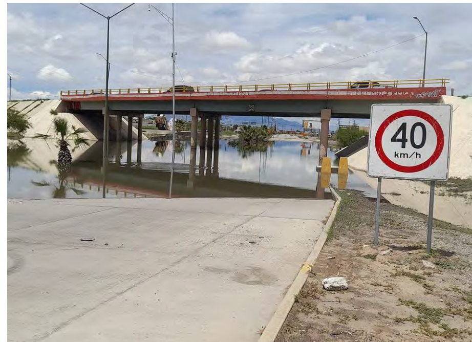
Pozo de captación en máxima capacidad Fuente: Elaboración propia,2021
