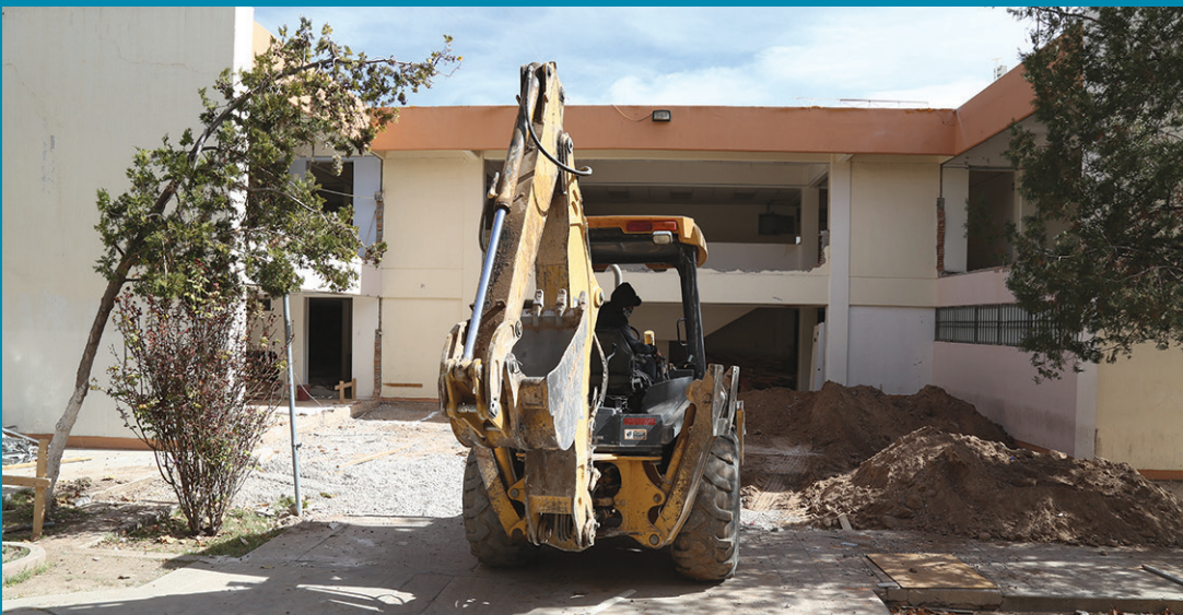
Las obras fueron acordonadas para evitar accidentes
