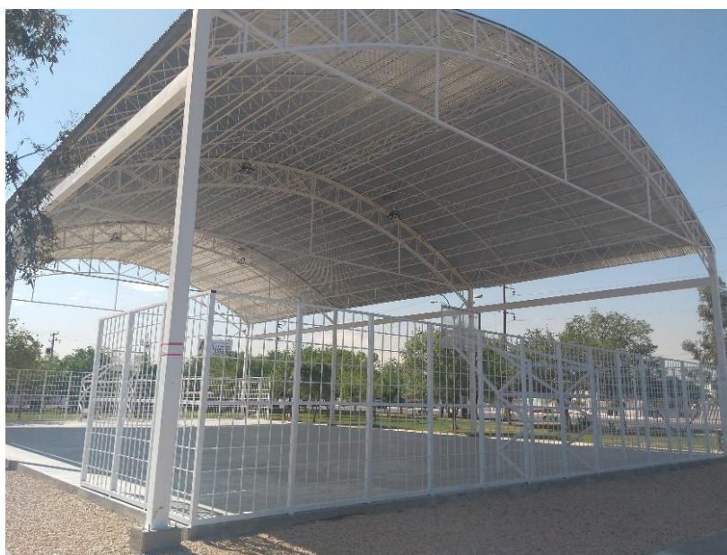
Figura 9. Cubierta tipo domo. (Archivo del autor, 2018).
