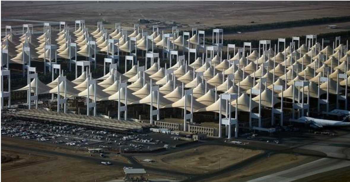
Figura 4. Aeropuerto Jeddah, Arabia Saudita, 1981, (Prezoa, 2014).
