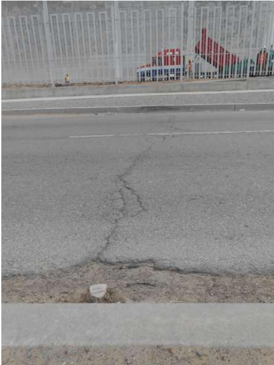
*Ilustración 6 Grietas transversales en pavimento asfáltico*
