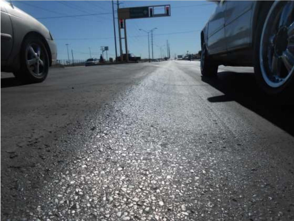
*Ilustración 8 Falla por corrugación en pavimento asfáltico*
