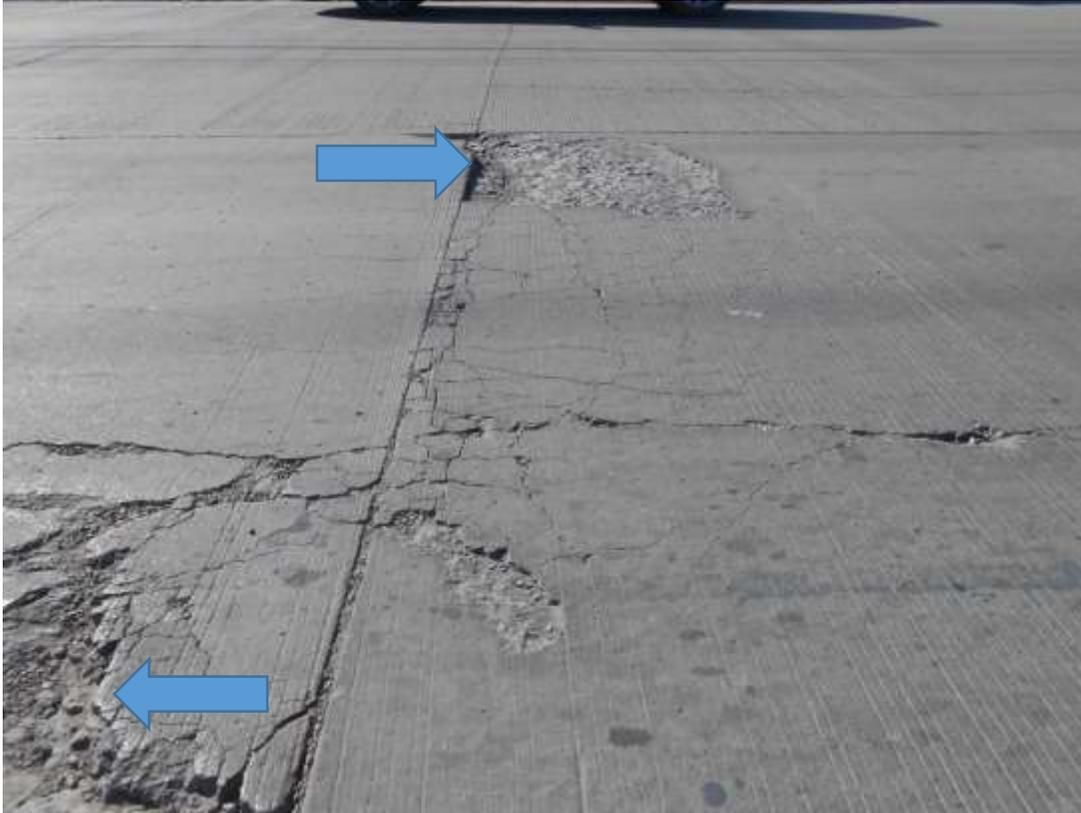
*Ilustración 28 Falla por bache en pavimento hidráulico*
