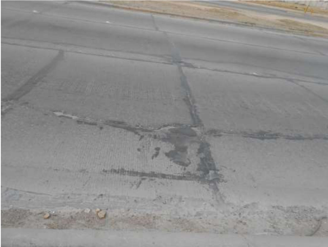
*Ilustración 23 Falla por deficiencia de material de sello en pavimento hidráulico*
