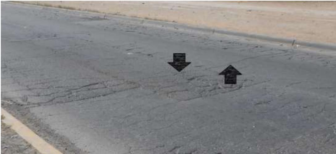
*Ilustración 11 Falla por grieta transversal debido a junta fría en pavimento asfáltico*
